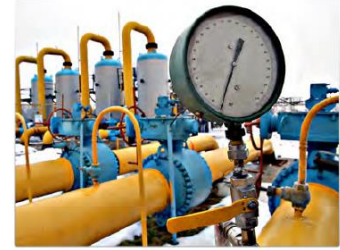
Görsel 2.39: Bir boru hattında akışkan basıncı kontrol altında tutmak için kullanılan manometre
